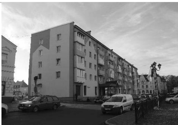
Фото 15. Внешнее состояние объекта.
