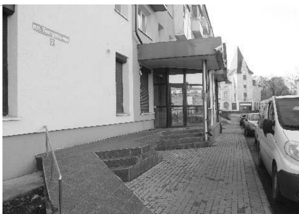
Фото 6. Внешнее состояние объекта.
