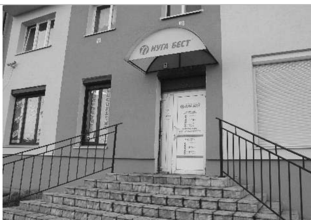
Фото 2. Внешнее состояние объекта.
