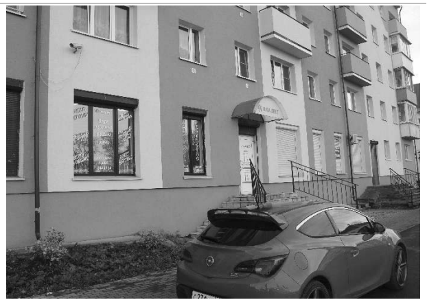
Фотография 3.2. Внешнее состояние объекта
