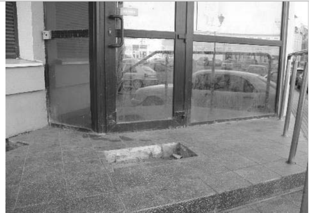
Фото 8. Внешнее состояние объекта.
