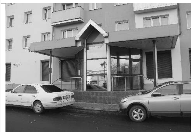
Фото 5. Внешнее состояние объекта.
