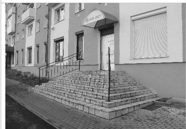
Фото 3. Внешнее состояние объекта.
