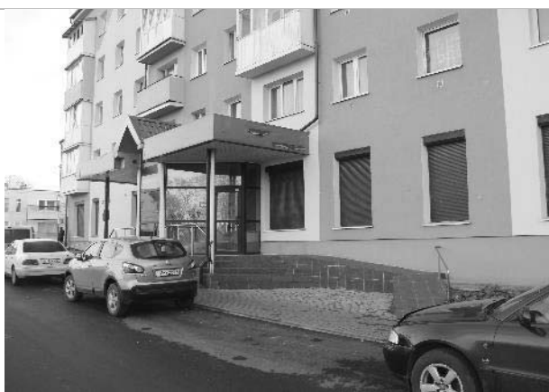
Фото 4. Внешнее состояние объекта.
