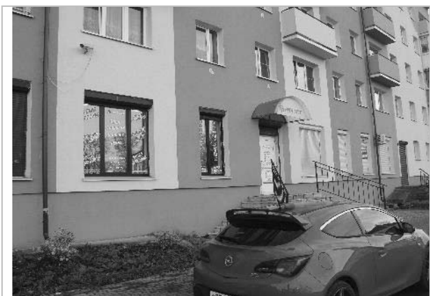
Фото 1. Внешнее состояние объекта.
